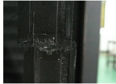
圖 67. 碳纖修補破壞情形
