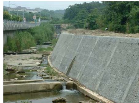
圖 3. 野溪護岸、底床之治理工程照片
