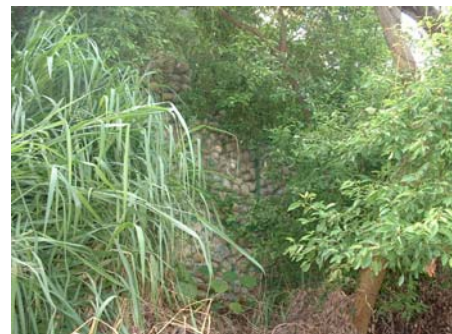
圖 4. 格框、箱籠擋土牆工程照片
