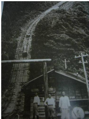
圖 3. 伏地索道運材實況 (資料來源：八仙山林場史話。台北市：農委會林務局。頁 65，張賜福，2004b)
